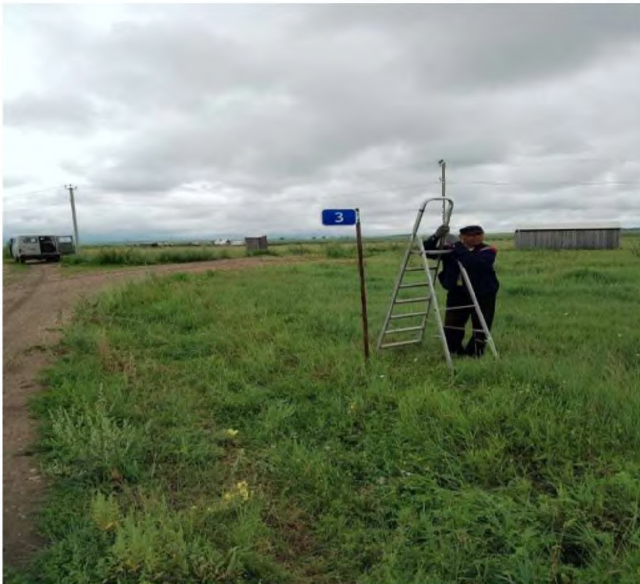
Установка дорожных знаков на автомобильной дороге местного значения «Капсал-Батхай»
